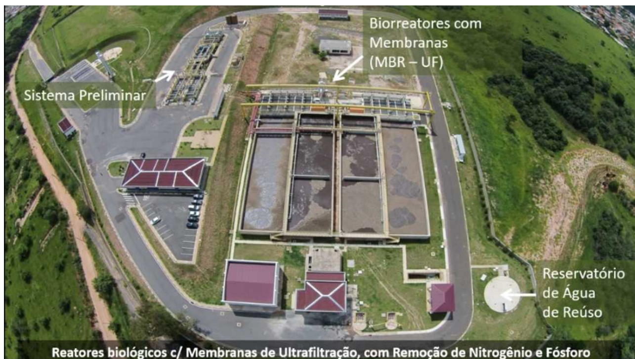
Figura 3. Imagem aérea da Estação Produtora de Água de Reúso – EPAR Capivari II
