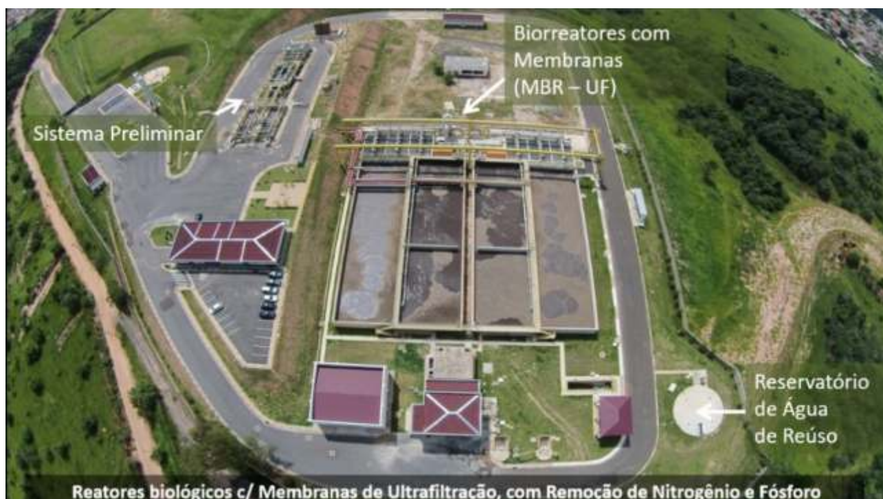
Figura 1. Imagem aérea da Estação Produtora de Água de Reuso – EPAR Capivari II.
