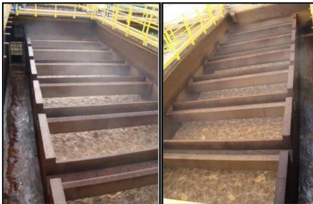
Figura 12: Filtro da ETA 03 em processo de limpeza. Fonte: SANASA (2021).
