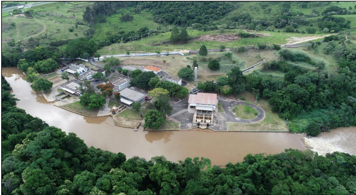
Figura 30: Ponto de captação e adução de água bruta, rio Atibaia SANASA Campinas.
