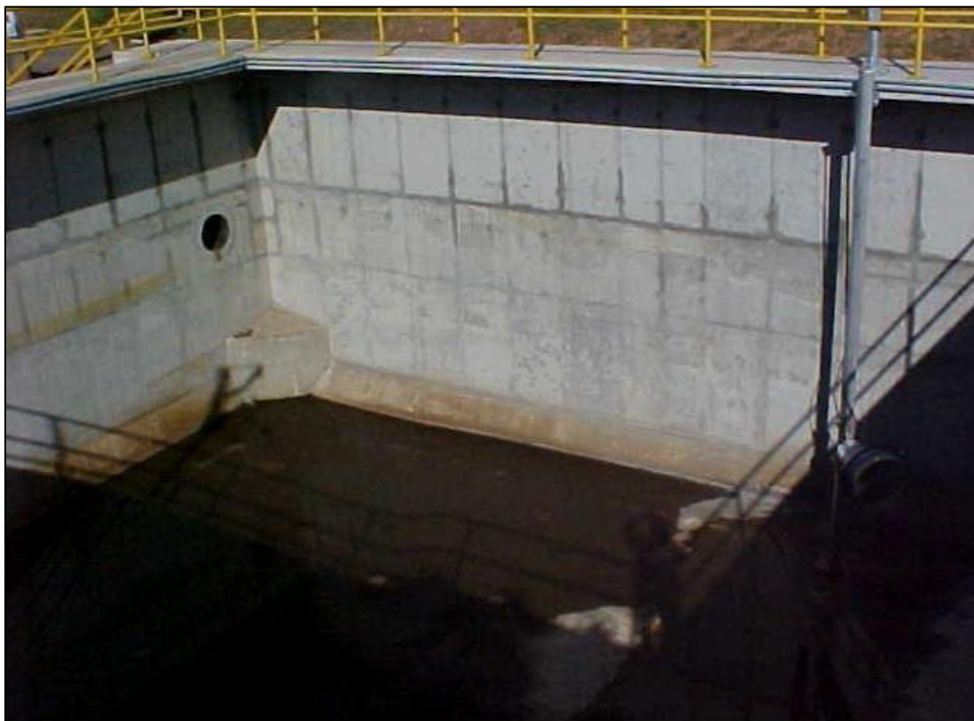
Figura 15: Vista interna do tanque de equalização. Fonte: SANASA (2021).
