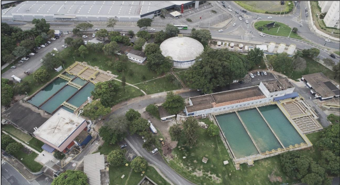
Figura 32: Estações de Tratamento de Água 1 e 2 (ETA's 1 e 2) – SANASA Campinas.
