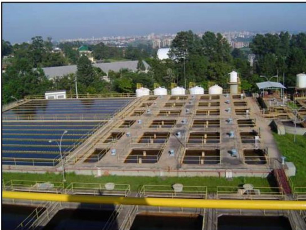
Figura 9: Vista superior dos Floculadores da ETA 04.
