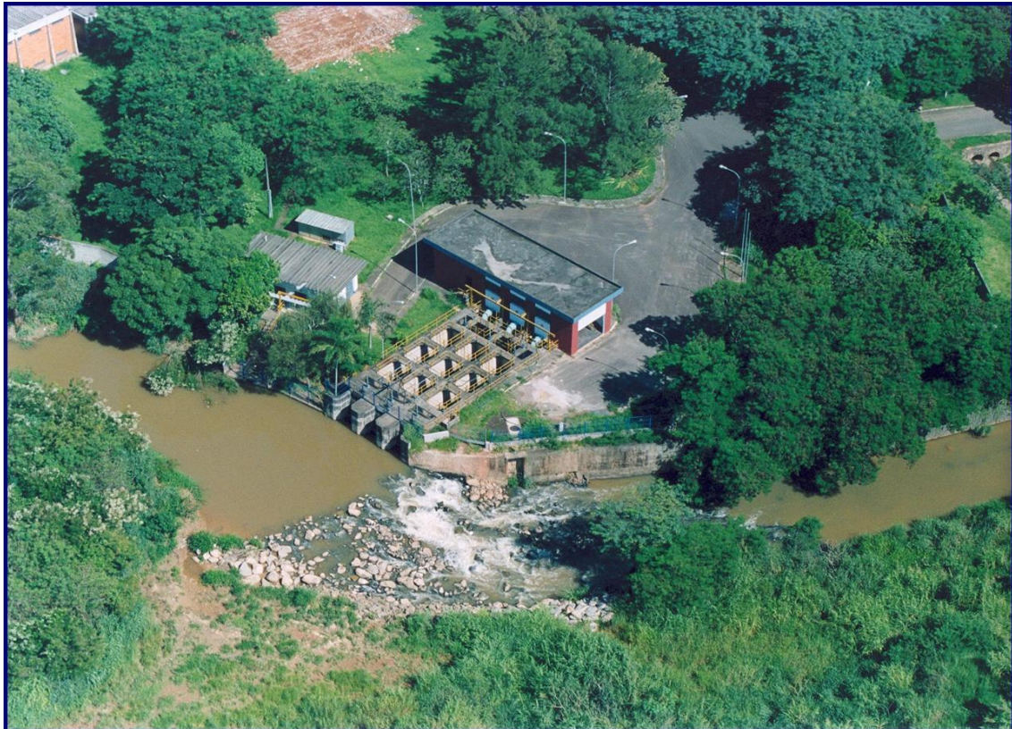
Figura 37: Ponto de captação e adução de água bruta, rio Capivari – SANASA
