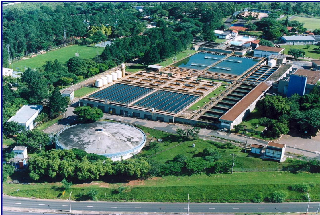
Figura 35: Estações de Tratamento de Água 3 e 4 (ETA's 3 e 4) – SANASA Campinas.
